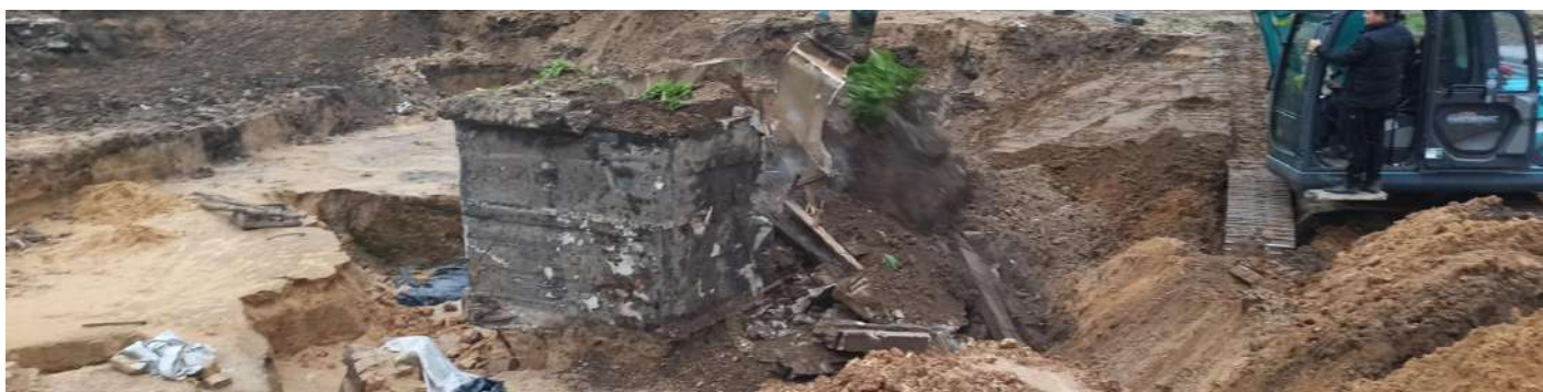
363. Perkasa Nr. 14 – demontuojama XX a. įrengto garažo duobės konstrukcija. Vaizdas iš R.
