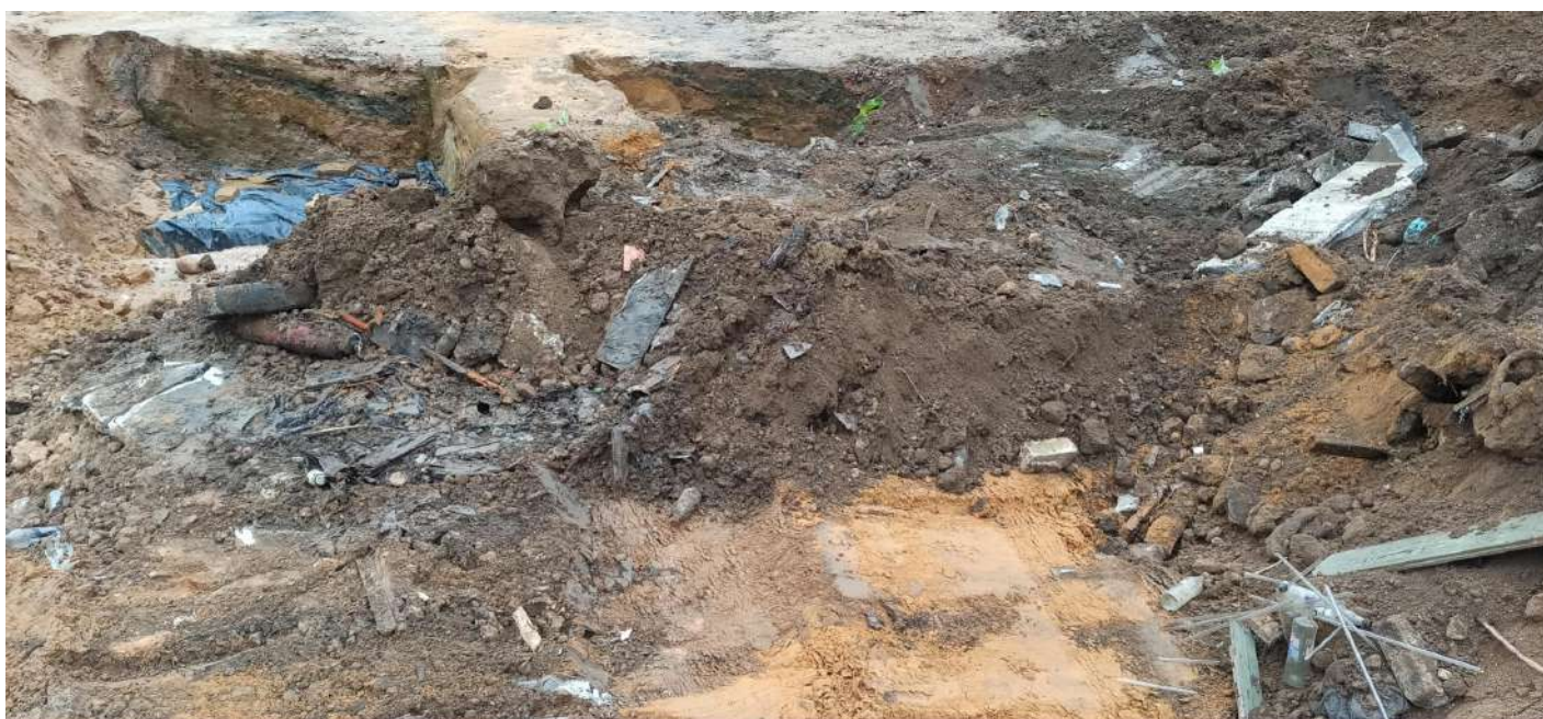
364. Perkasa Nr. 14 – demontuojama XX a. įrengto garažo duobės konstrukcija. Vaizdas iš ŠR.
