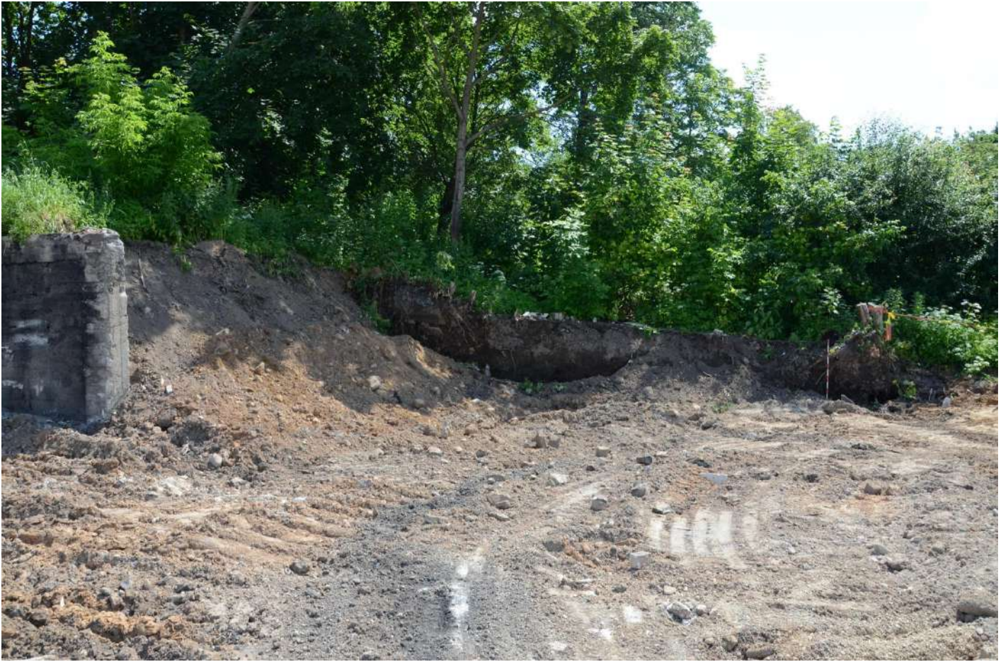
7. Žvalgymai P, PV sklypo dalyje demontuojant garažus ir atraminę sieną. Vaizdas iš Š.
