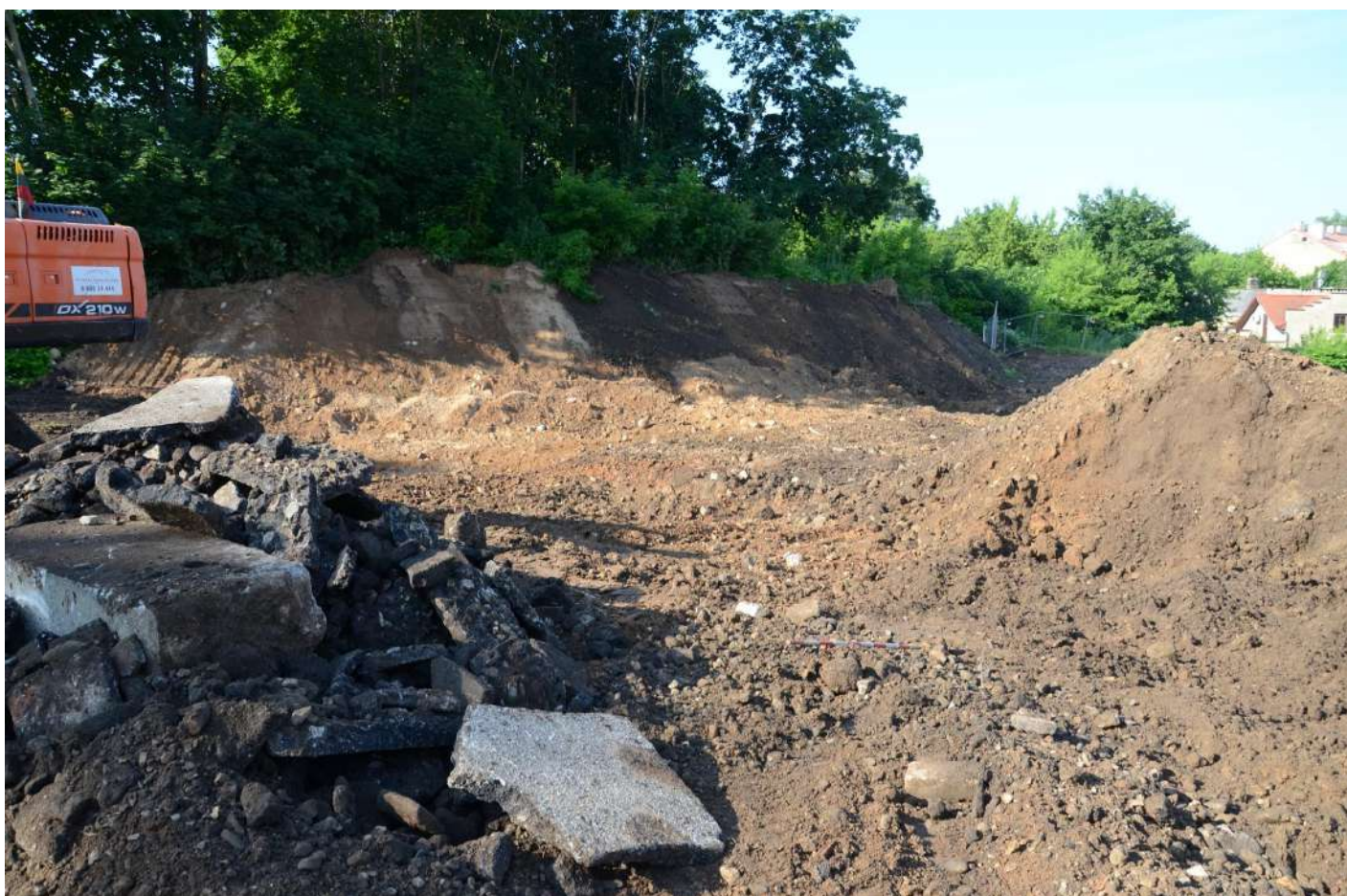
6. Žvalgymai P, PV sklypo dalyje demontuojant garažus ir atraminę sieną. Vaizdas iš Š.
