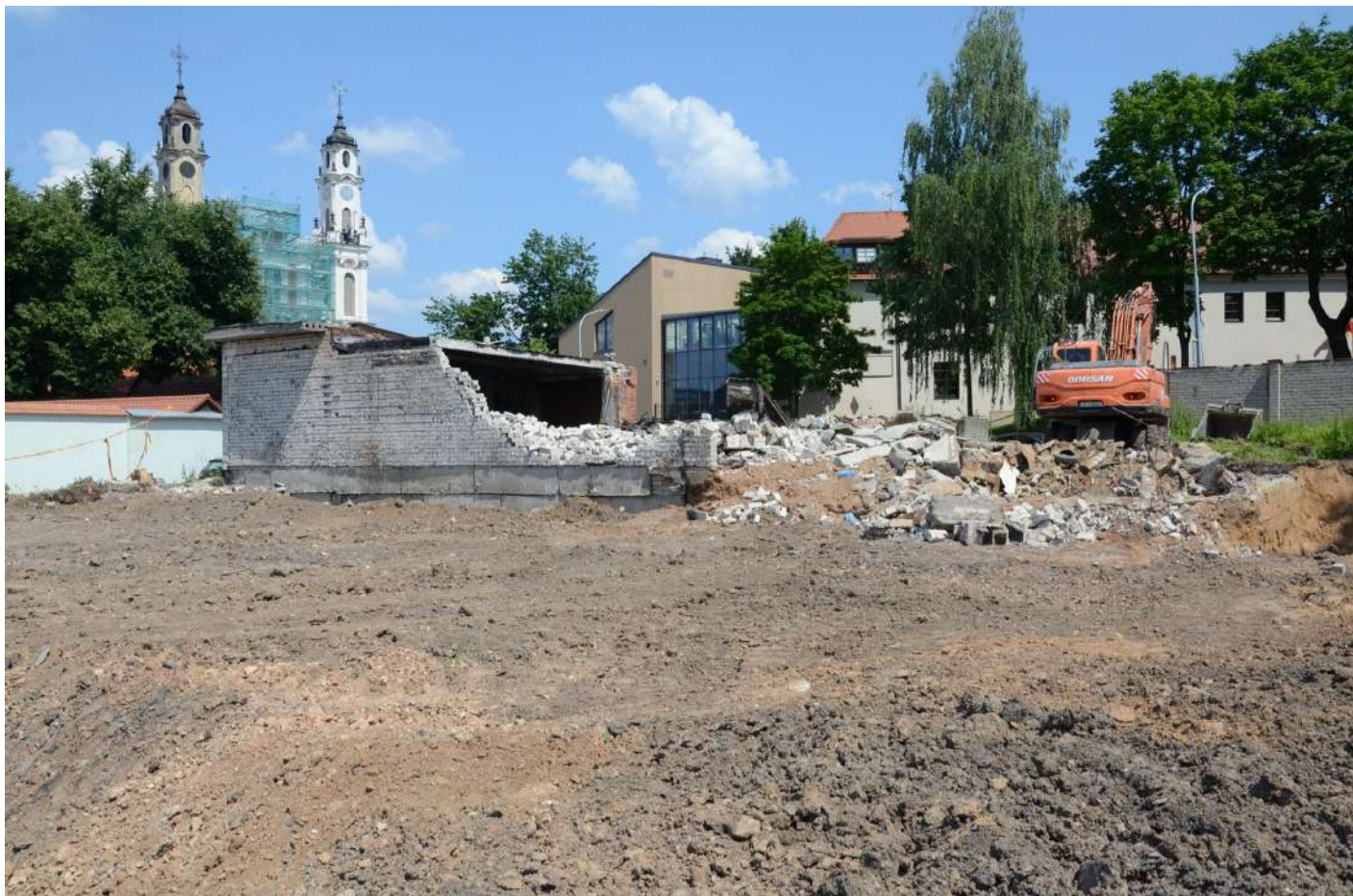
3. Žvalgymai Š, ŠR sklypo dalyje demontuojant garažus ir nuimant asfalto dangą. Vaizdas iš PV.
